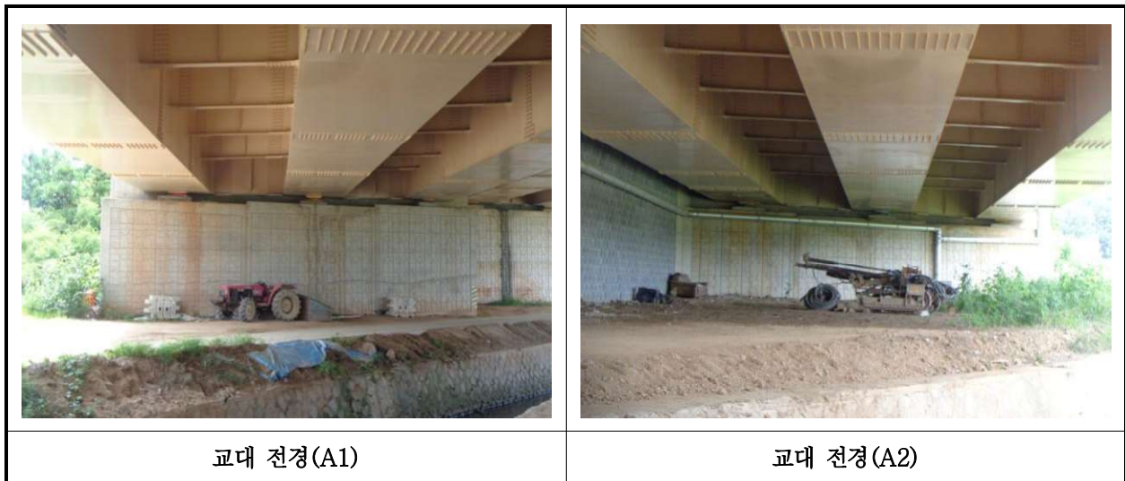
【사진 13.3.29】 교대 전경
