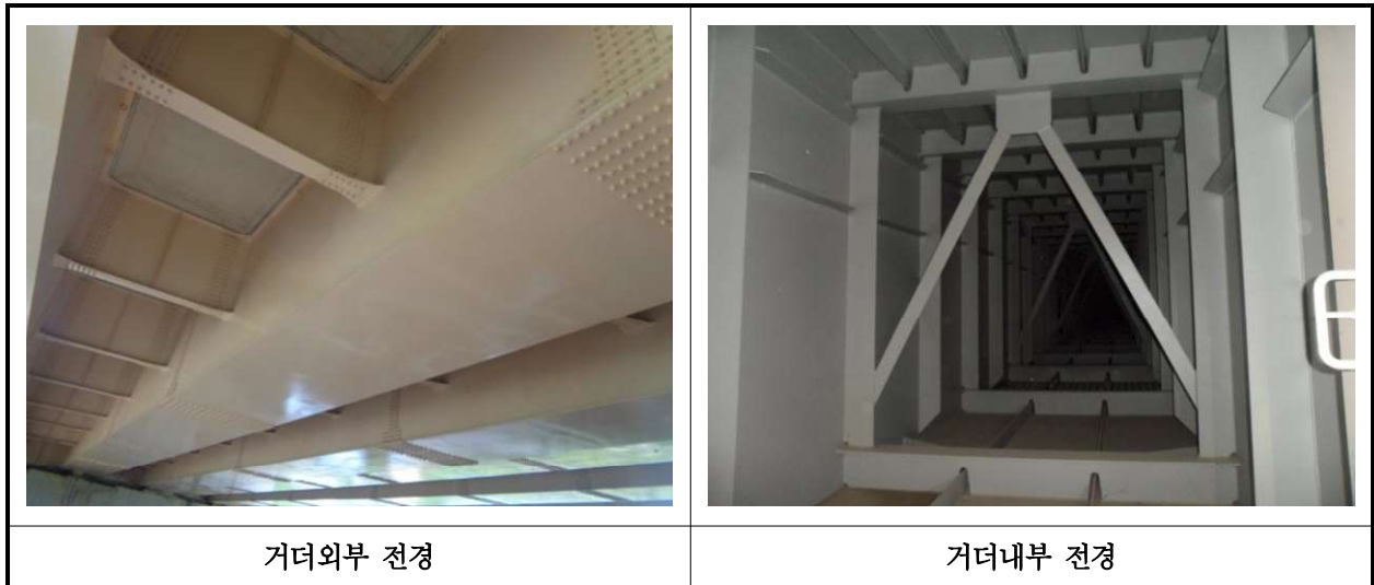
【사진 13.3.25】 거더 전경
