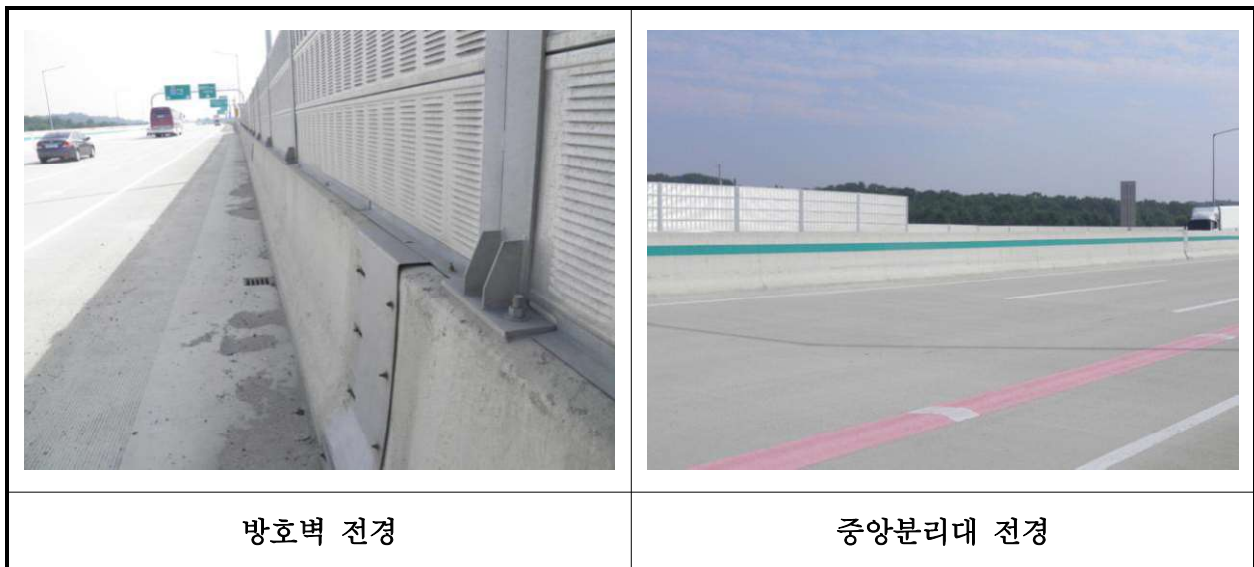
【사진 13.3.21】 방호벽 및 중앙분리대 전경
