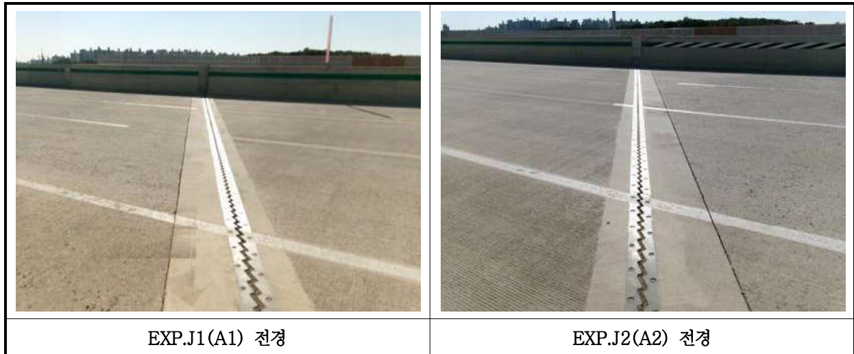
【사진 13.3.35】 신축이음장치 전경
