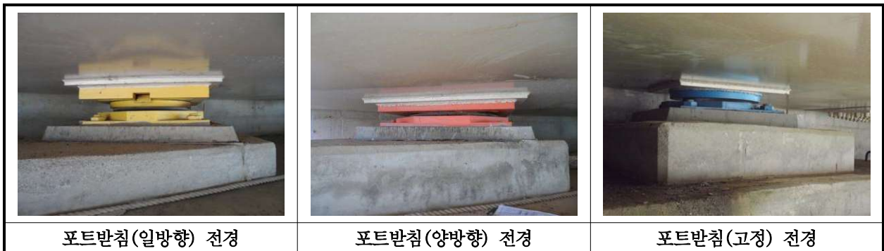
【사진 13.3.31】 교량받침 전경
