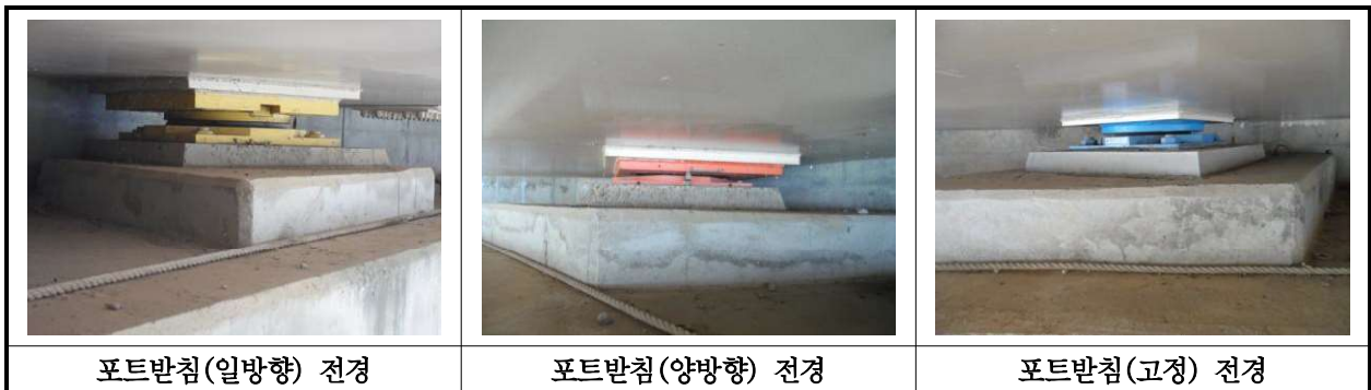
【사진 13.3.10】 교량받침 전경
