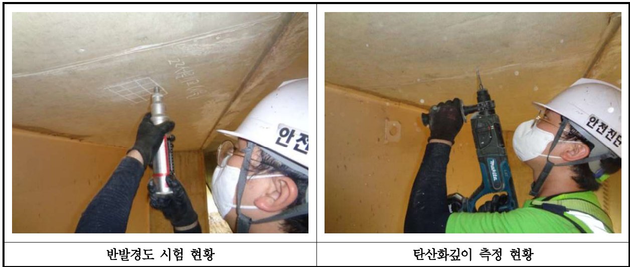
【사진 13.4.1】 콘크리트 내구성조사 현황
