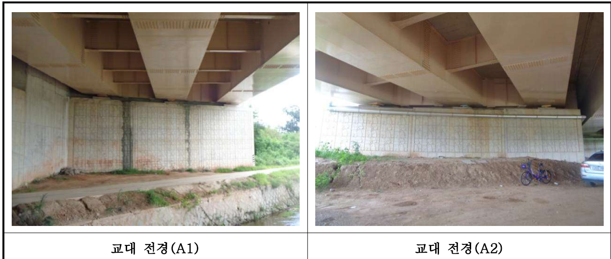
【사진 13.3.8】 교대 전경
