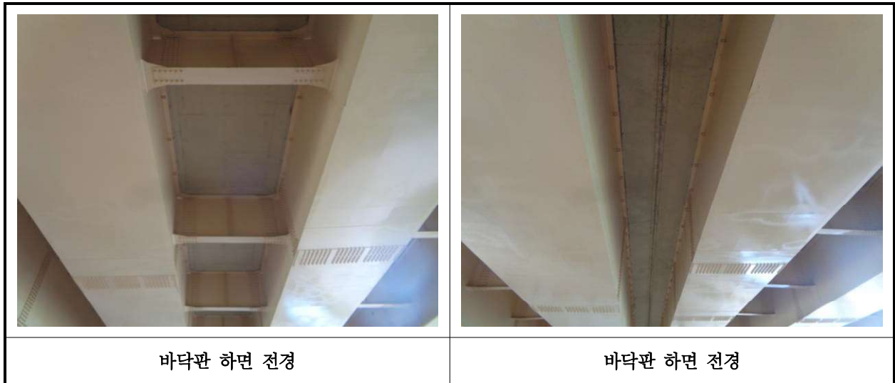
【사진 13.3.2】 바닥판하면 전경
