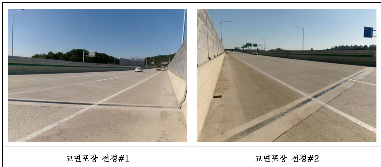
【사진 13.3.38】 교면포장 전경
