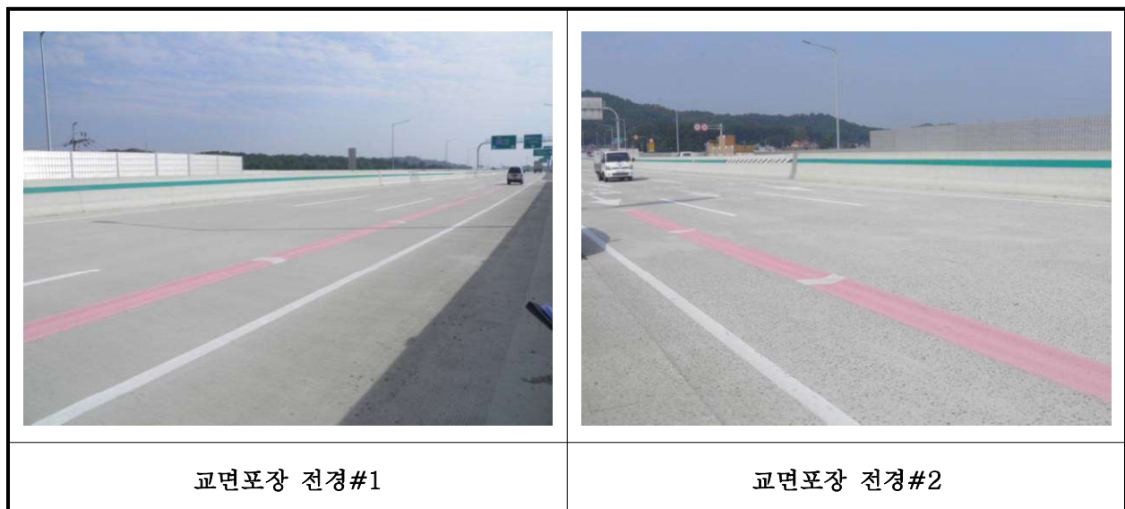
【사진 13.3.17】 교면포장 전경
