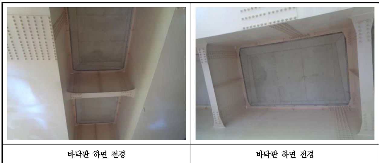
【사진 13.3.23】 바닥판하면 전경
