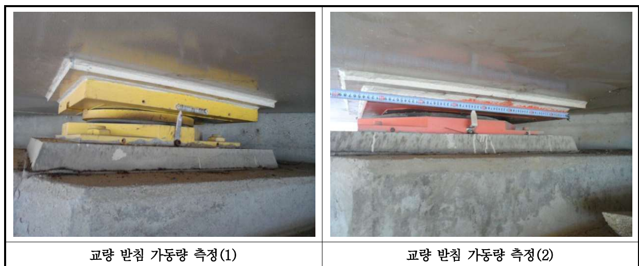
【사진 13.3.34】교량받침 이동량 측정
