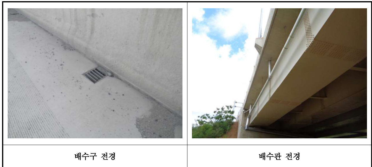
【사진 13.3.19】 배수시설 전경
