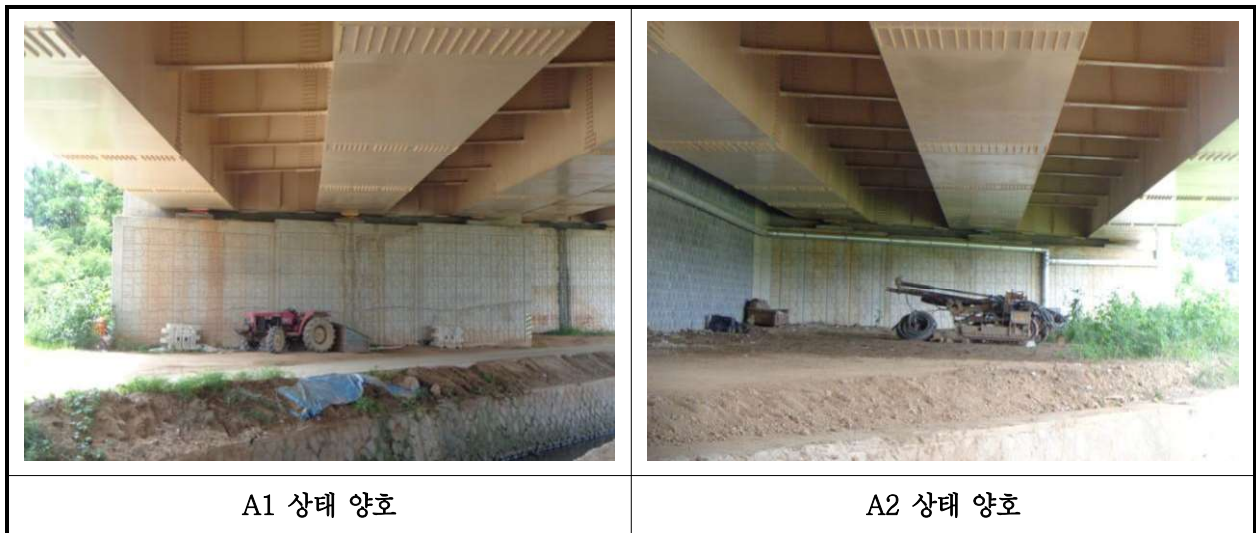
【사진 13.3.30】 교대 손상현황
