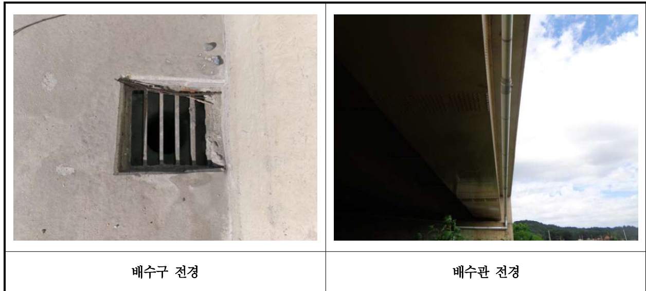
【사진 13.3.40】 배수시설 전경
