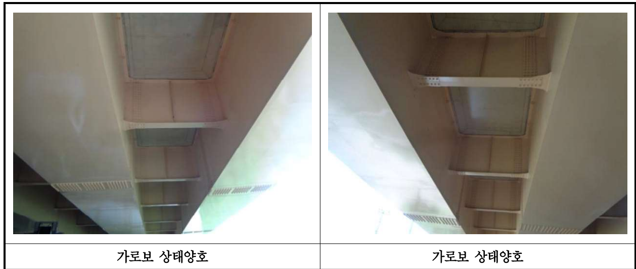
【사진 13.3.28】 가로보 손상현황
