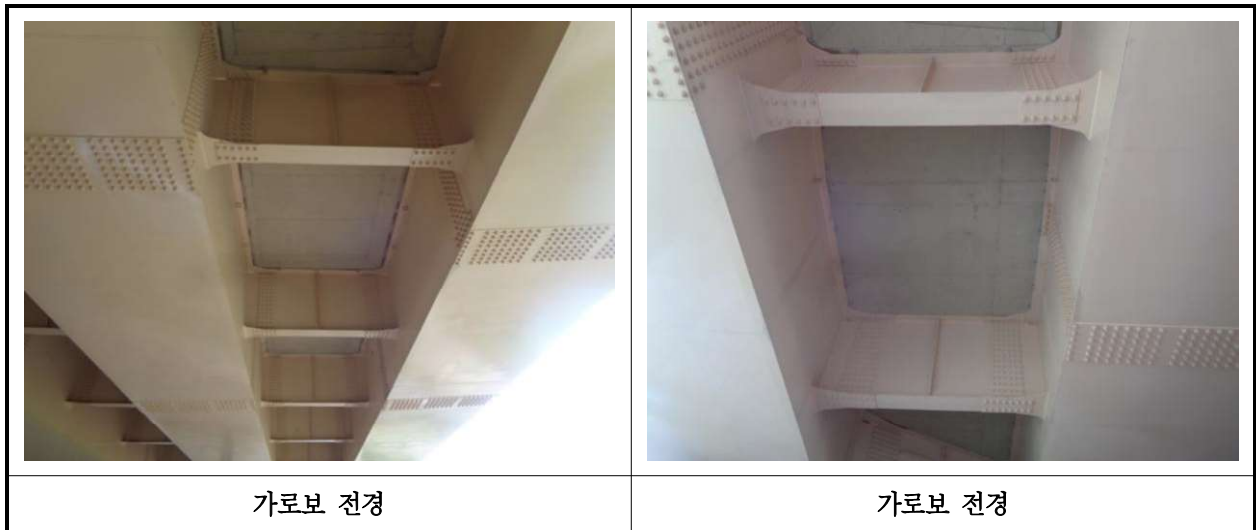
【사진 13.3.6】 가로보 전경
